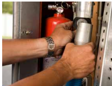
Die Anlage startet automatisch beim Montieren des Schlauches und stoppt sofort, wenn der Schlauch entfernt wird.
